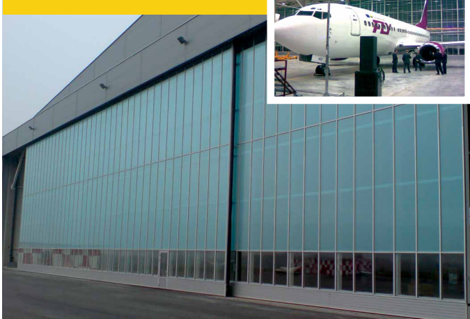
HANGAR UND INDUSTRIETORE
