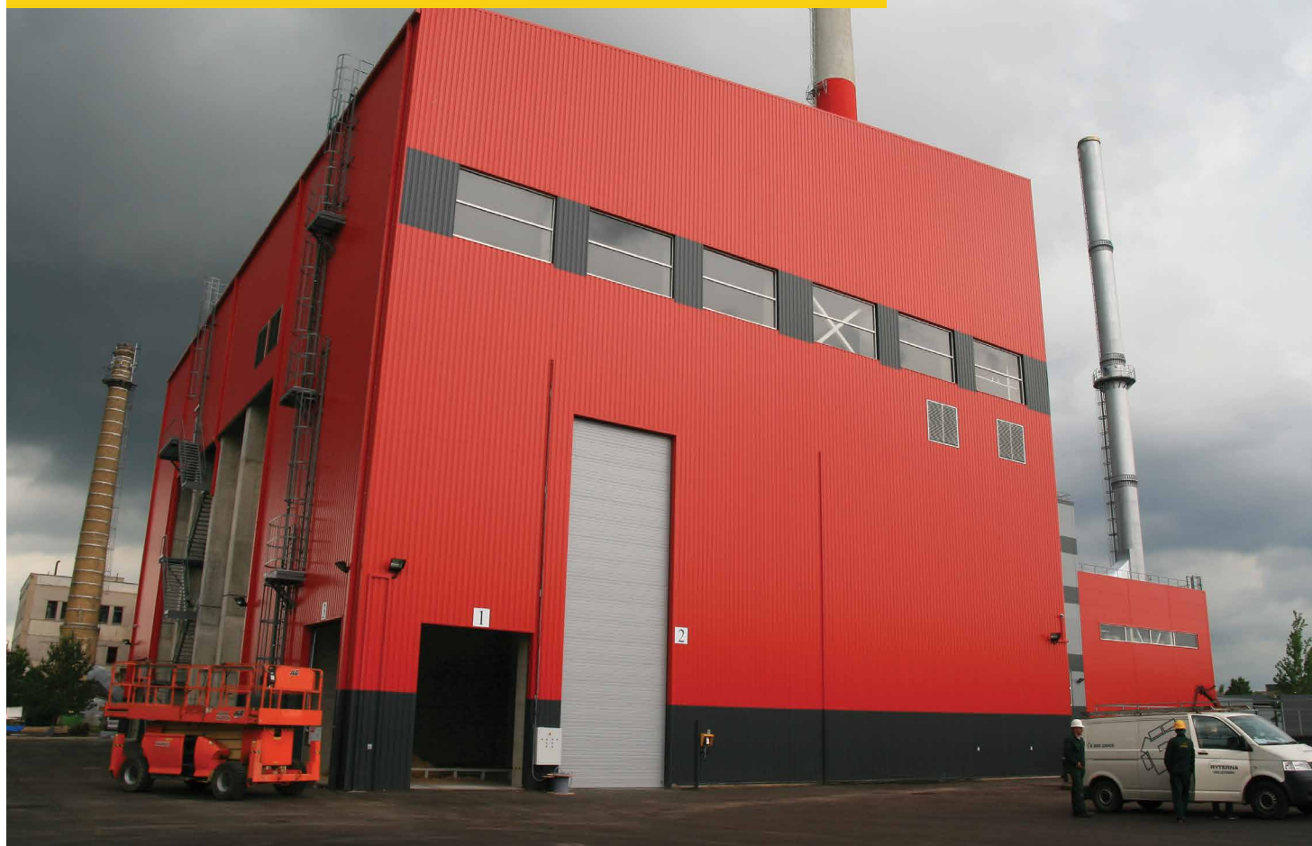
PORTES DE CENTRALE ÉLECTRIQUE - 4,5 MÈTRES DE LARGE ET 11 MÈTRES DE HAUT
