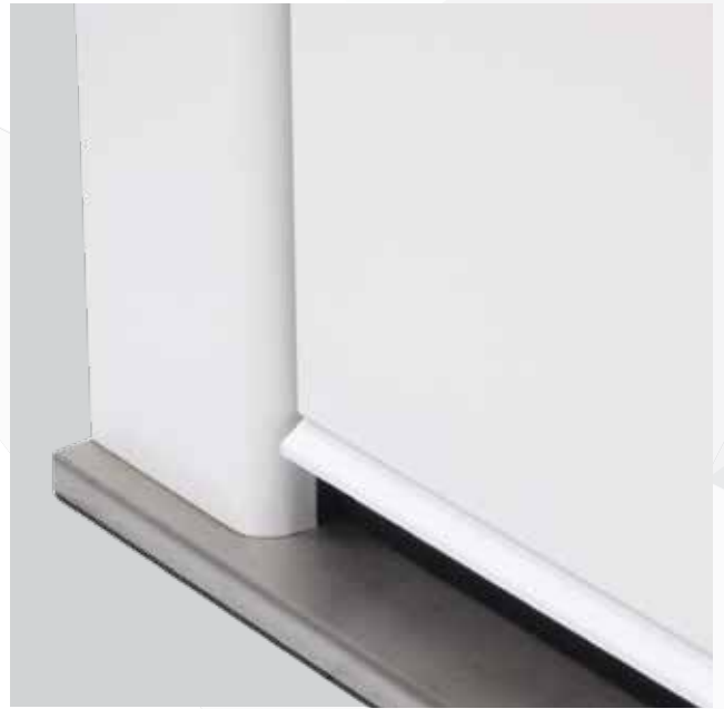
2. Anta rientrata rispetto al telaio. Telaio stonato
